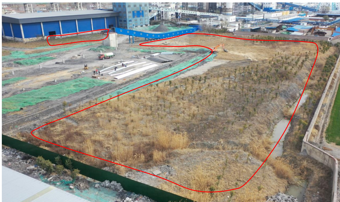
地面光伏区域
