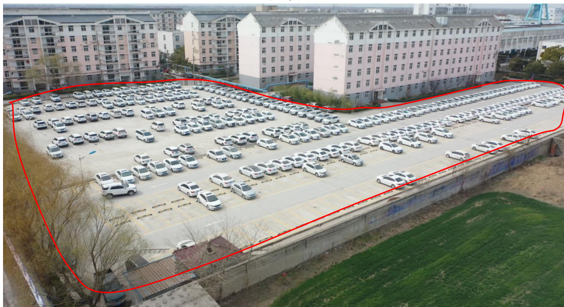
屋顶(停车场车棚)光伏区域
