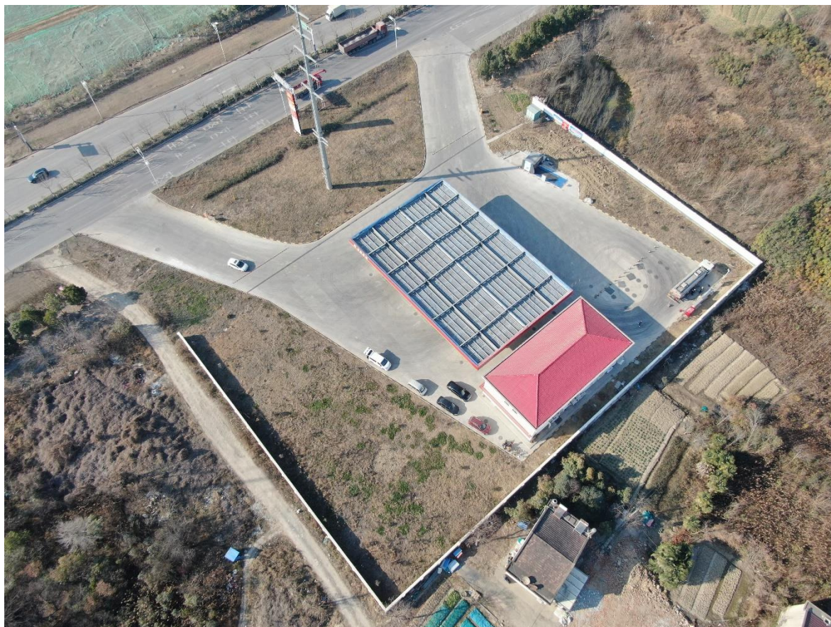
图1.4 工程现状图（已完工）
