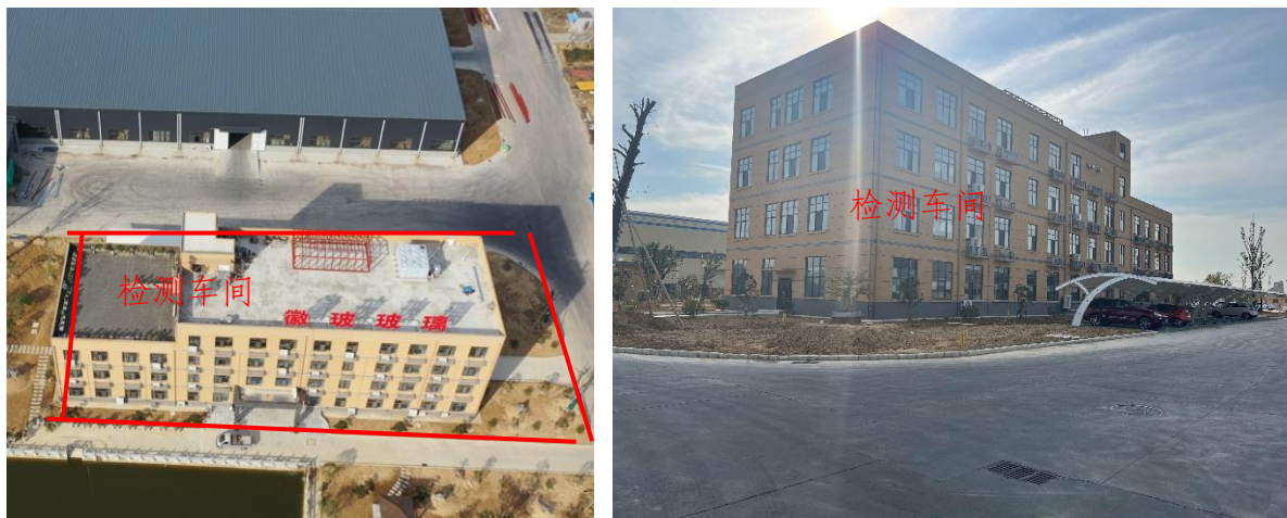
图 1.4 检测车间现状
