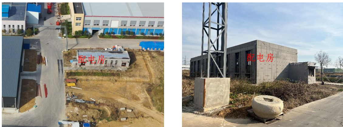
图 1.5 检测车间现状
