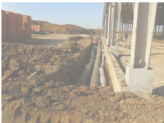
雨水管道现状
