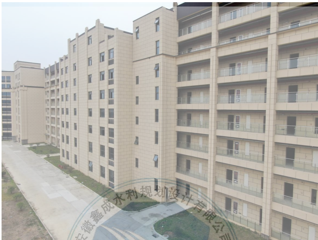
图 1.2 研发中心大楼现状图
