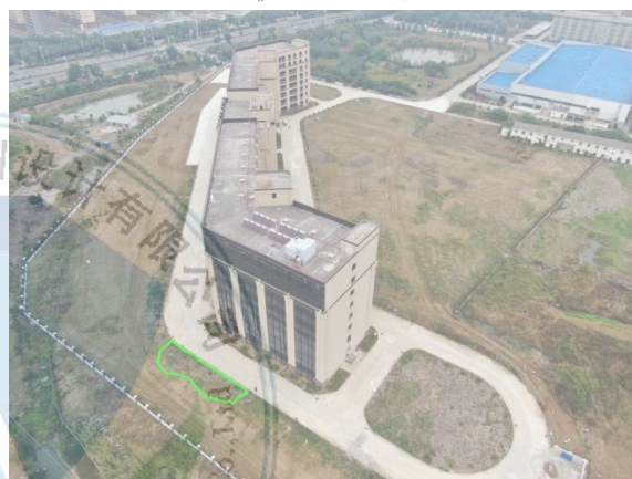
临时堆土场现状
