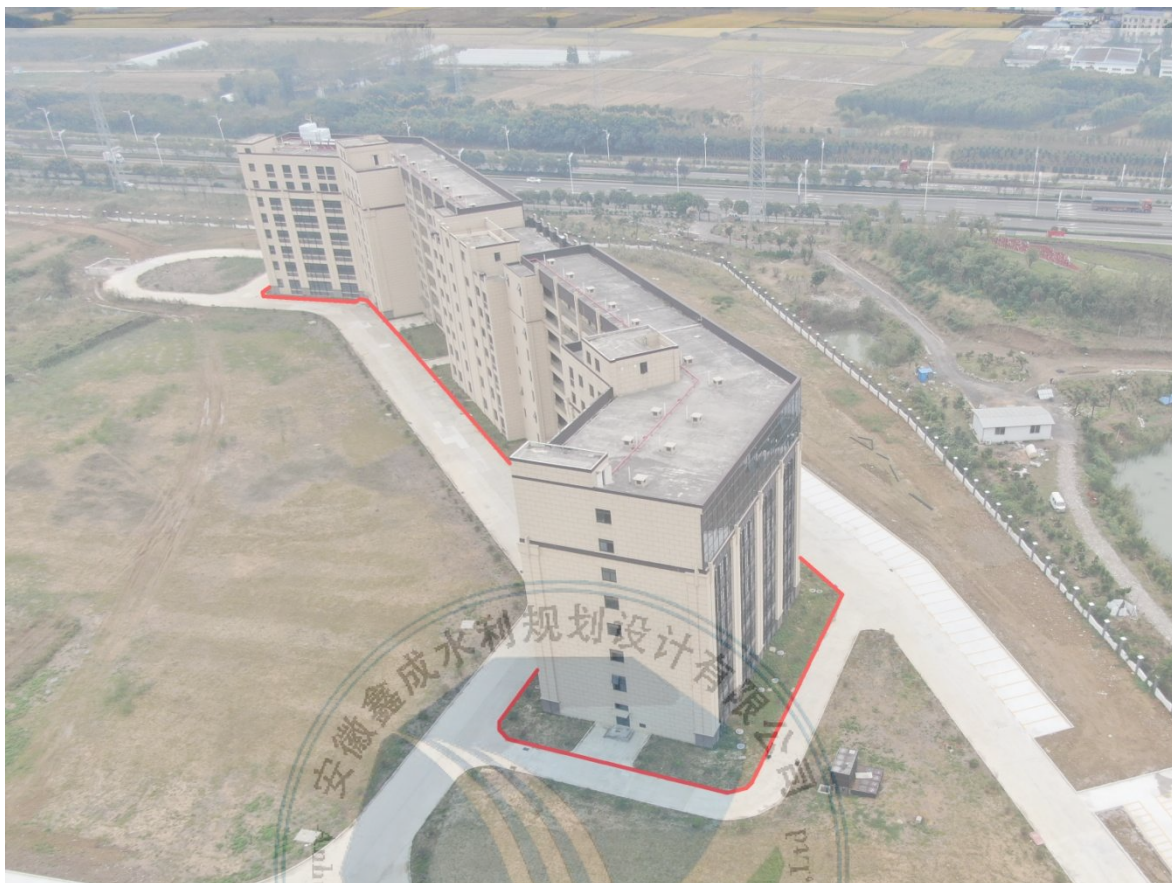
图 1.1 项目现状航拍图
