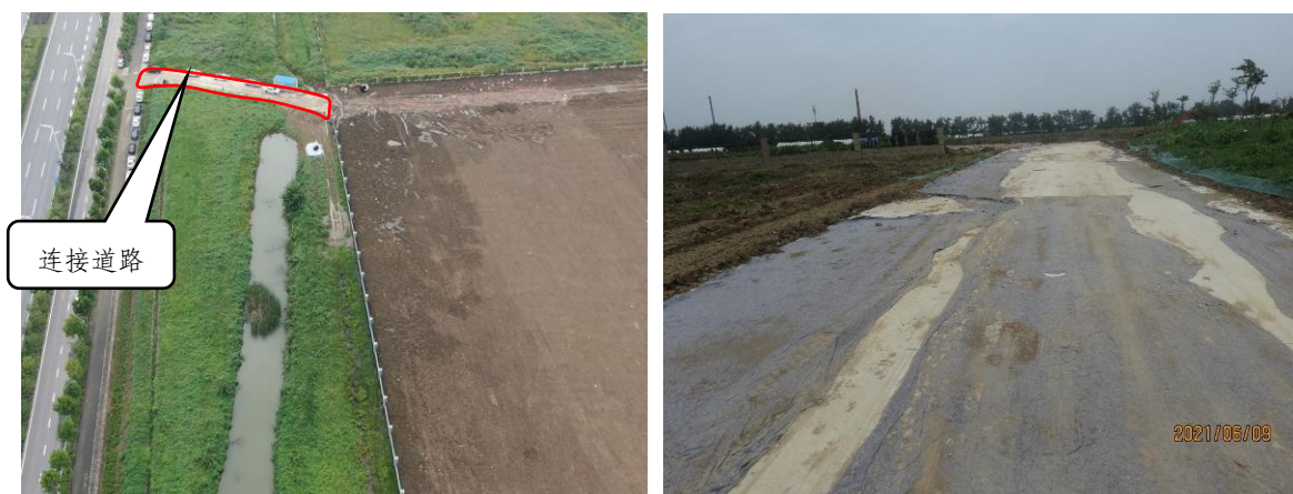
图 1.3 施工道路现状
