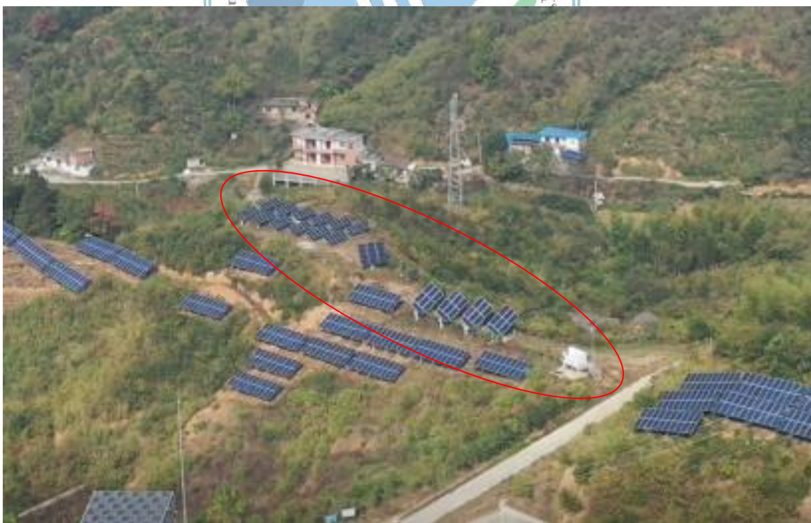
施工场地（现状）
