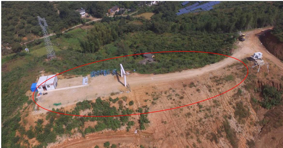
施工场地（施工期）
