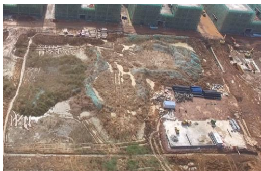
1#临时堆土场现状
