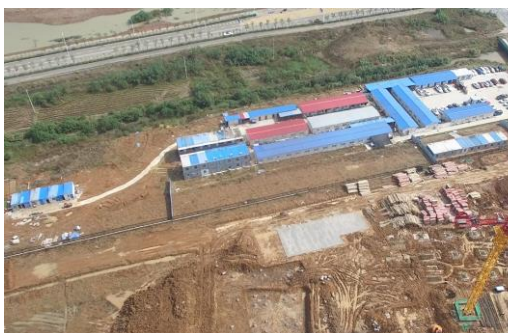
1#施工临建（施工项目部及生活区）
