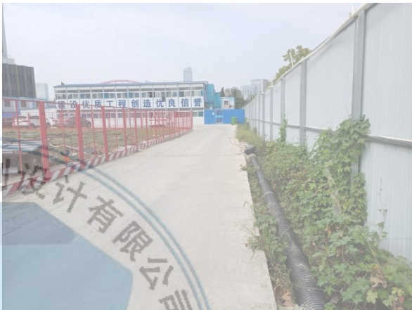
场外临建工程及施工扰动区 临时排水管道
