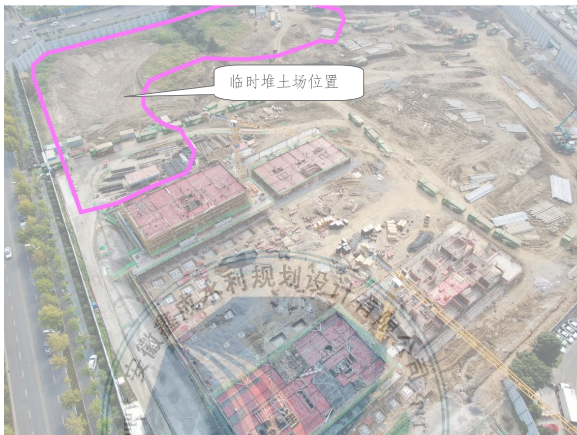
图 2.10 项目区临时堆土场现状
