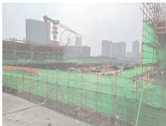
在建建构筑物场地现状
