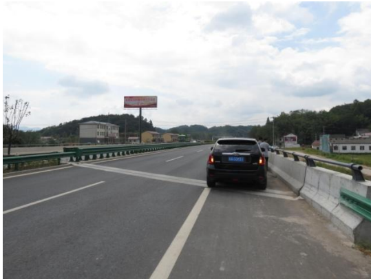
戴家河中桥现状
