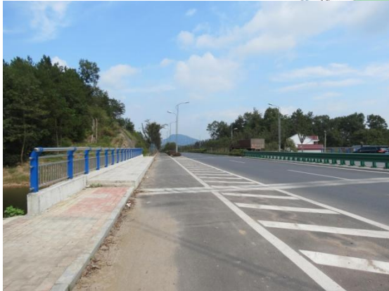
黄加院中桥现状
