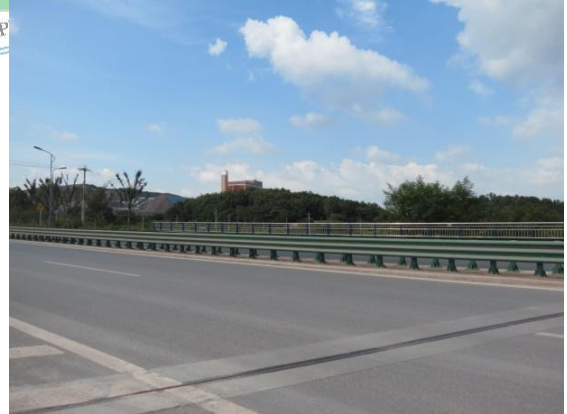
石壁冲中桥现状
