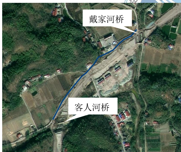
临时施工道路位置
