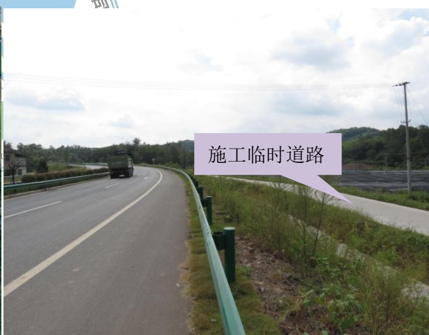
临时施工道路现状
