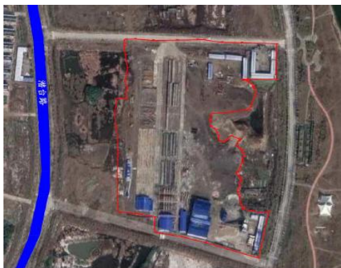
2#弃渣场（施工过程中）
