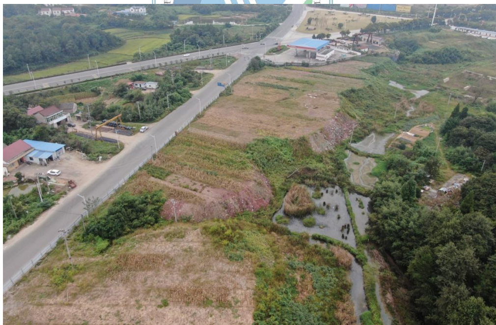
1#弃渣场航拍（2021年9月）
