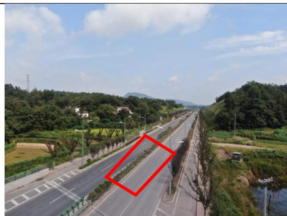
3#施工场地现状
