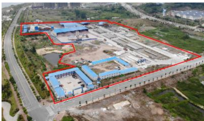
2#弃渣场（施工过程中）
