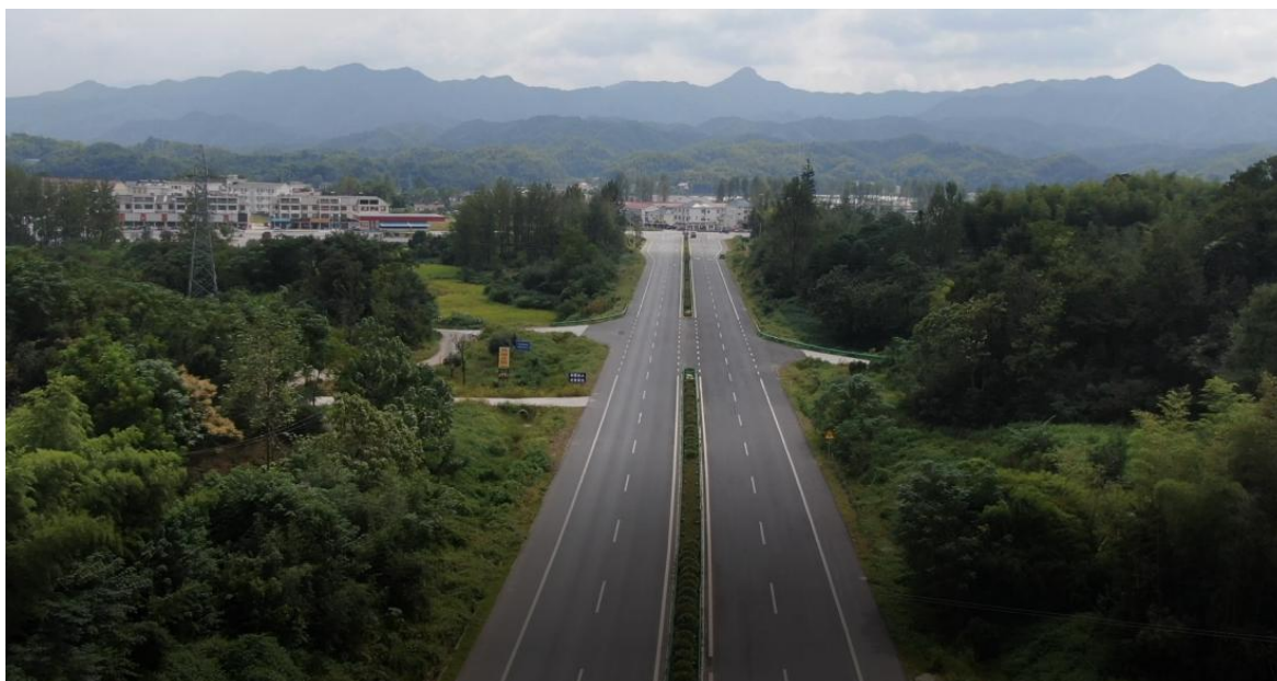
路线终点处现状航拍
