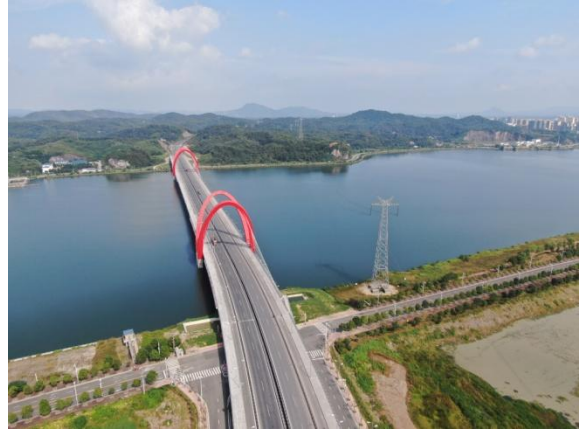
双湾大桥现状
