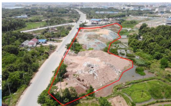
1#弃渣场航拍（2020年5月）
