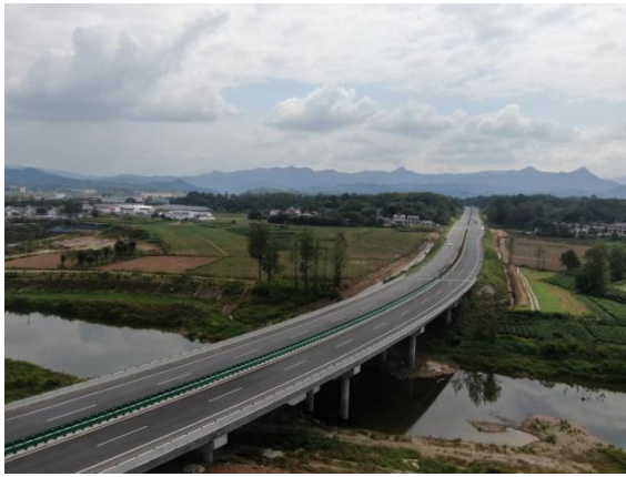
深水河大桥现状
