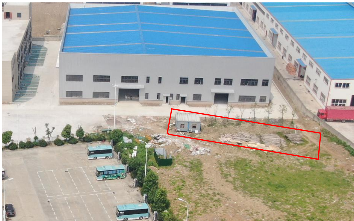
图 3.4 施工场地现状
