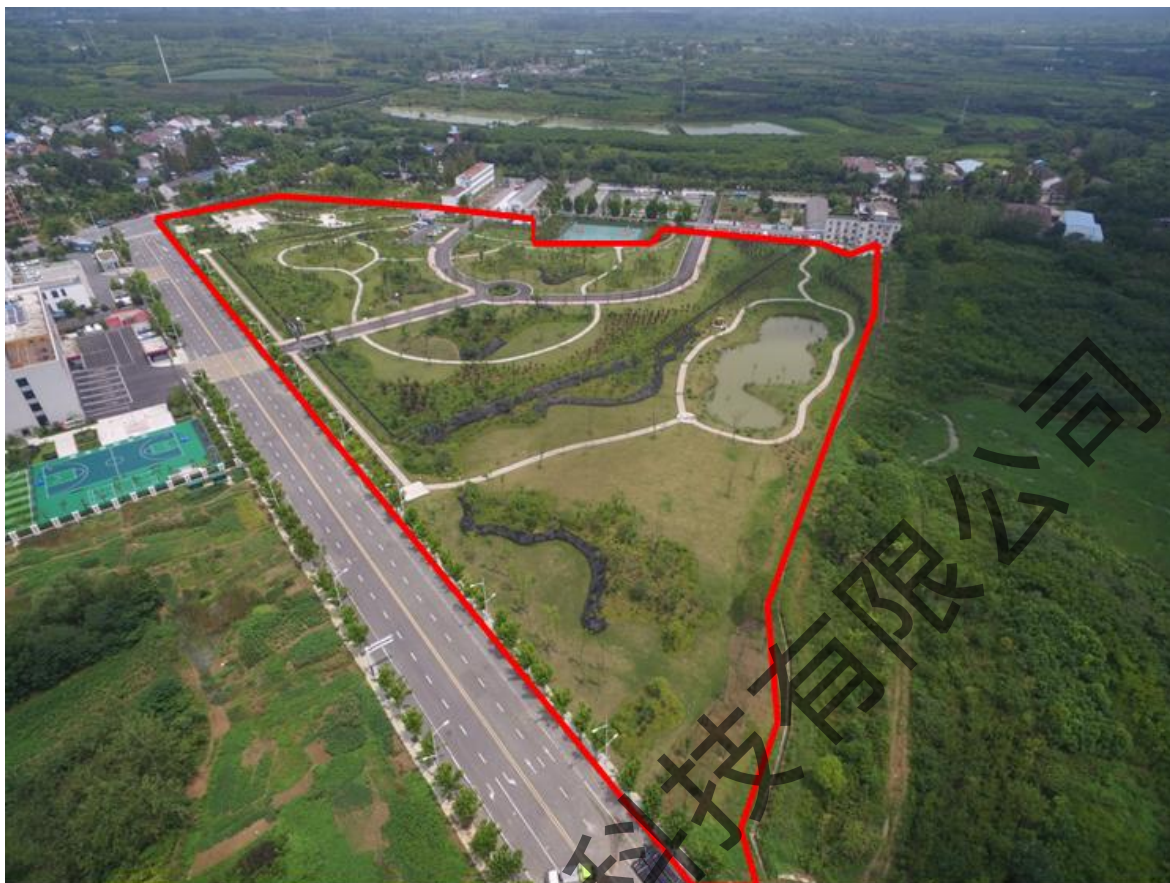
图 1.1 项目现状航拍图
