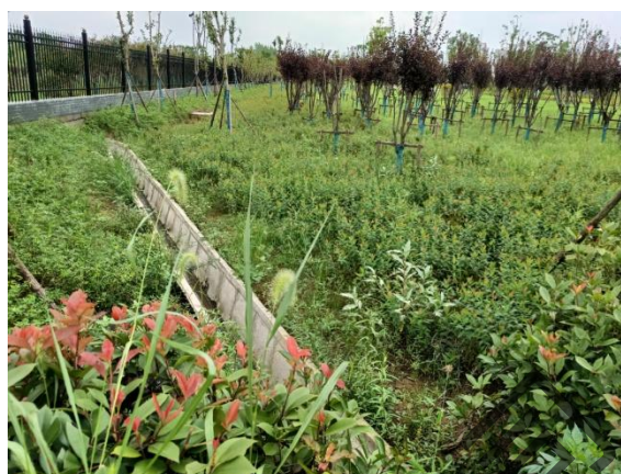
砼预制块排水沟
