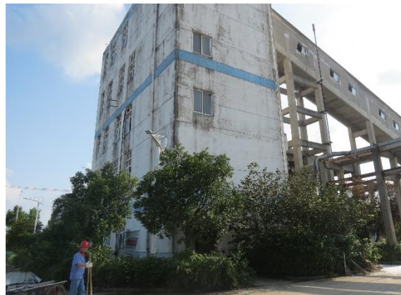
办公生活区现状
