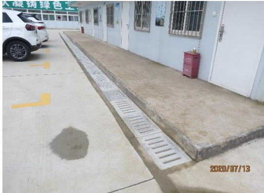
施工生活区临时排水沟
