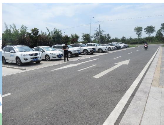
厂区进厂道路
