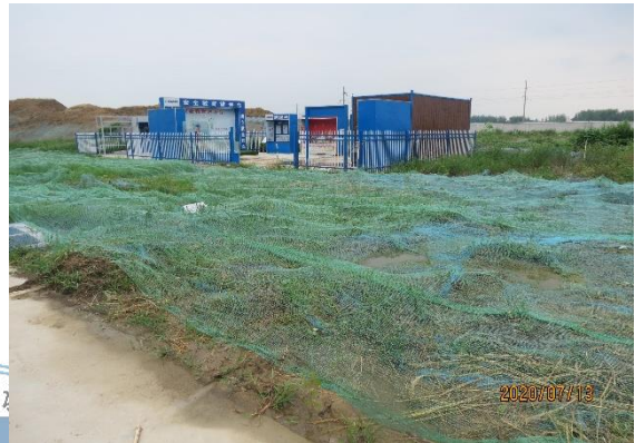
厂区苫盖措施
