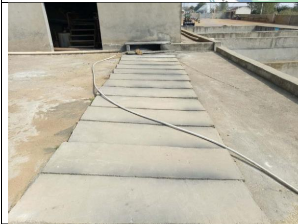
选矿工业区排水沟
