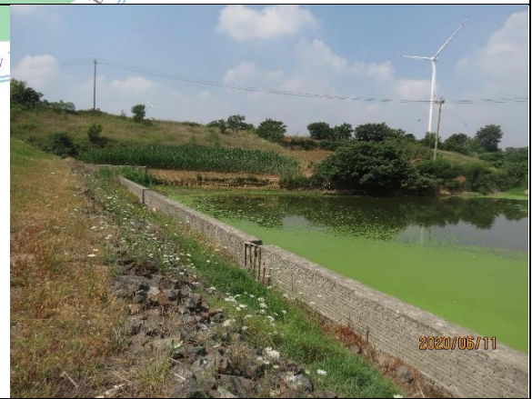
尾矿库区块石护坡
