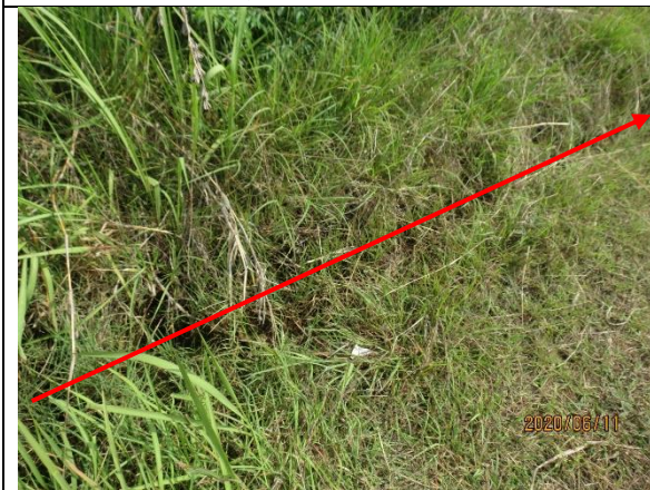
尾矿库区排水沟
