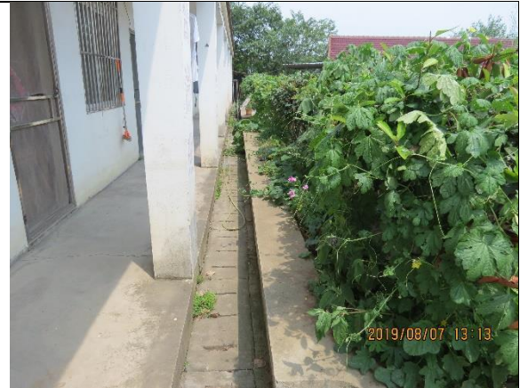
生活办公区排水沟
