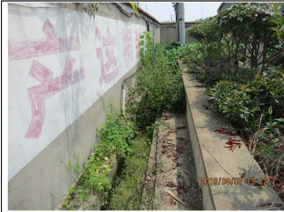
生活办公区排水沟
