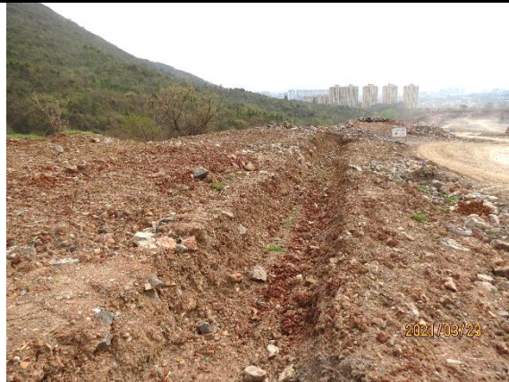
改建道路内侧排水沟（矿山道路区）
