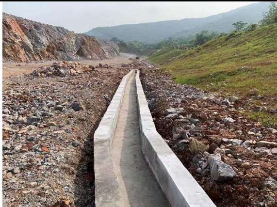
新建道路排水沟（露天采场区）
