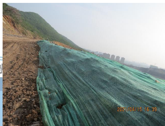
密目网苫盖（矿山道路区）
