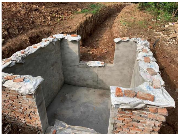
露天采场区沉沙池
