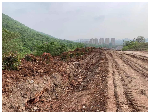
改建道路路肩灌木（矿山道路区）
