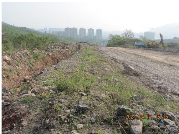
改建道路草籽（矿山道路区）
