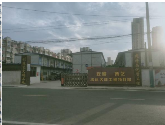
施工生产生活区现状
